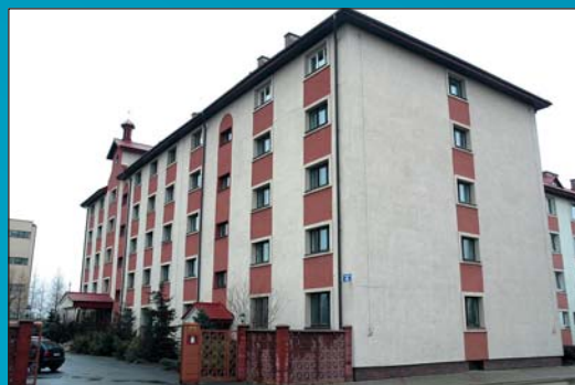
Budynek Seminarium po remoncie
