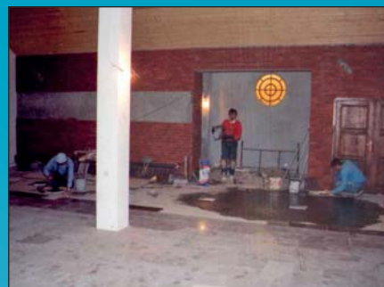
Budowa kaplicy domowej
